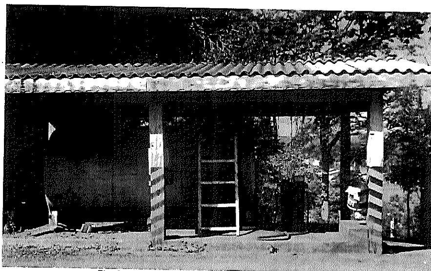
Fig. 3 – Pátio de Maquinas – Tanque de Abastecimento
