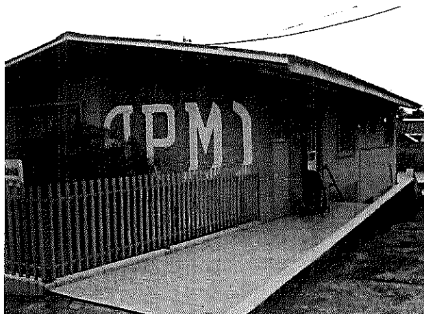
Fig. 1 – Vista Frontal do Prédio
