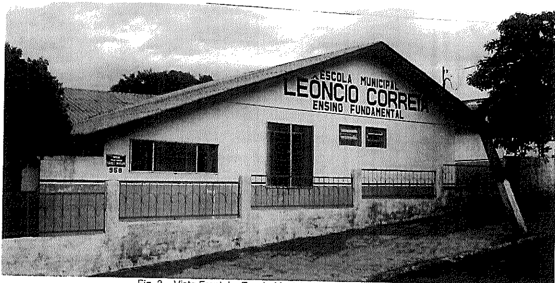
Fig. 3 – Vista Frontal – Escola Municipal Leôncio Correia
